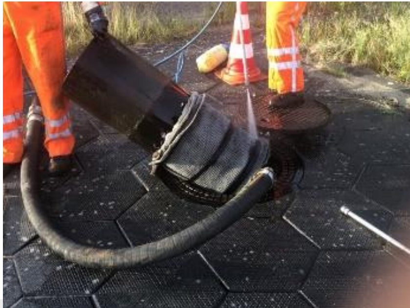
Foto: Controle ingebouwde onderdelen afscheidingsinstallatie
